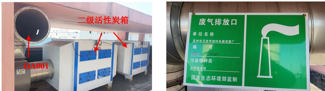
图 3.2-2 1#废气治理设施图（二级活性炭（DA001））、标识排照片
