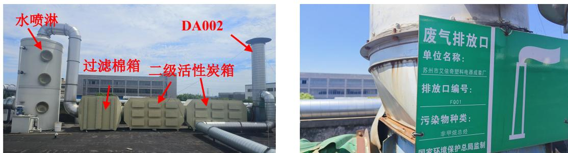
图 3.2-3 2#废气治理设施图（水喷淋+过滤棉+二级活性炭（DA002））、标识照片
