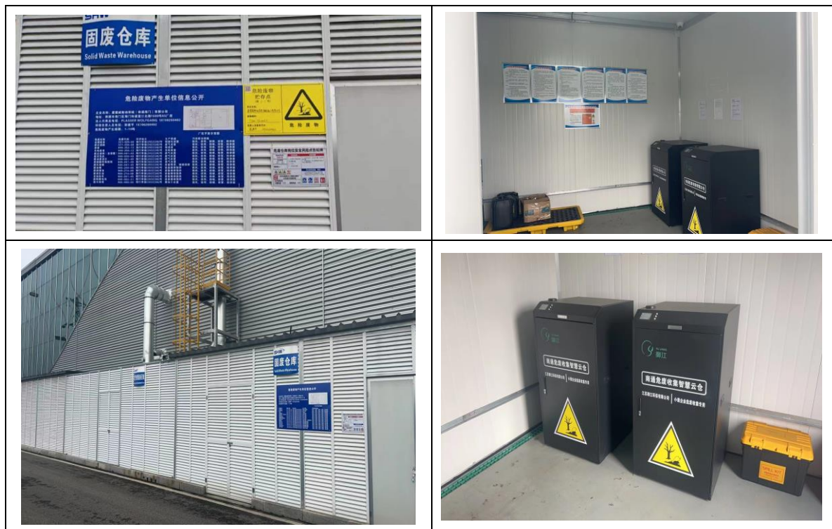
图 3-4 危废仓库建设现状
