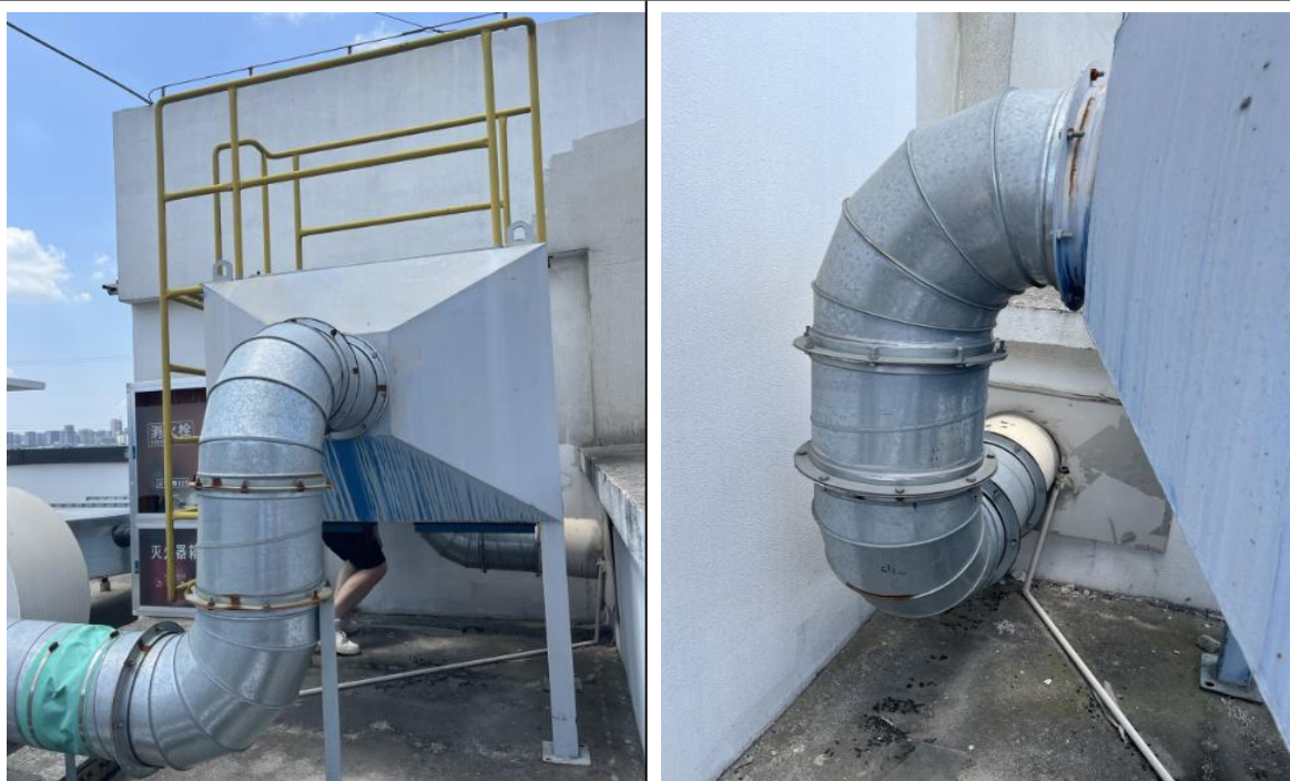
图 7-1 废气处理装置进口位置照片
