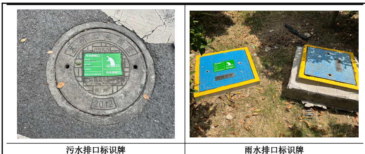
图 3-2 雨、污水排放口照片
